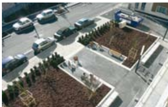
Les grandes fosses de plantation récupèrent les eaux de ruissellement des trottoirs.
