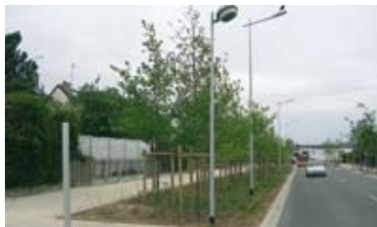
Noue arborée en rive de voie, Chartres. Il convient dans des sols très filtrants de rétablir une certaine étanchéité du fond des points d'eau pour ne pas polluer les nappes. Ces précautions renvoient à la loi sur l'eau.
