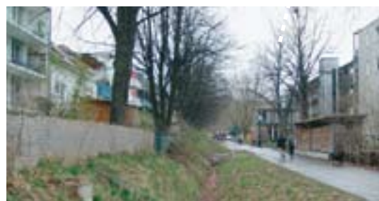
Fossé de récupération des eaux pluviales dans un quartier d'habitat.
