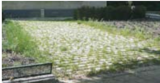
Le sol devient poreux et vivant grâce à la colonisation des joints par une strate herbacée.
