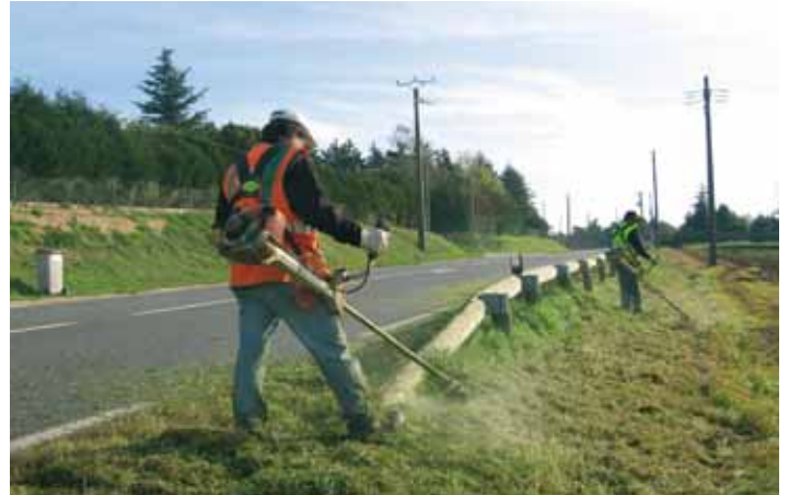
Le détourage des obstacles nécessite l'usage d'un matériel type débroussailleuse portable à fil nylon.
