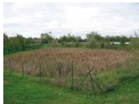
Les bassins de rétention des eaux de voirie
