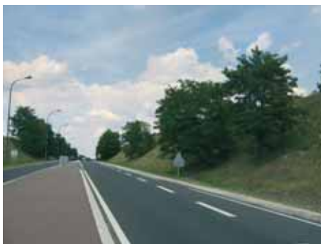
Les merlons, butte et talus
