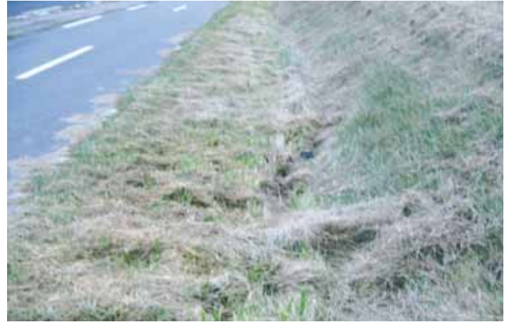
Les produits de fauche non exportés provoquent par accumulation le colmatage du réseau hydraulique.
