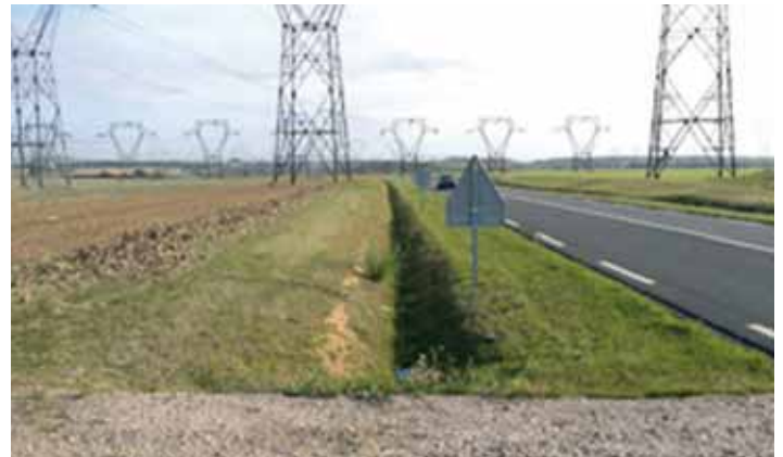
Evacuation des eaux de la plate forme grâce aux fossés et noues
