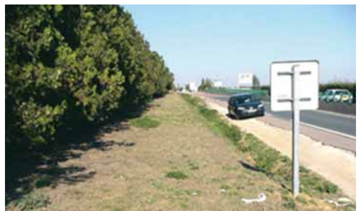
Support des panneaux d'information et de signalisation . Zone de sécurité ou de récupération pour les arrêts en dehors de la chaussée et les sorties de route
