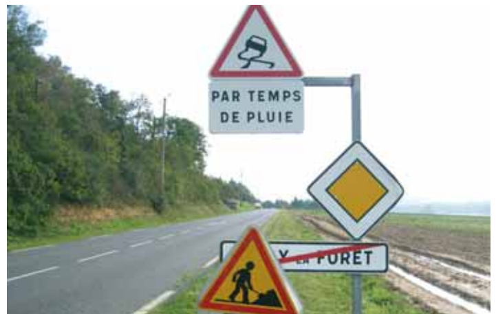
A éviter : une profusion de panneaux peut nuire à la lisibilité et à l'efficacité de la signalisation temporaire à l'approche d'un chantier mobile.
