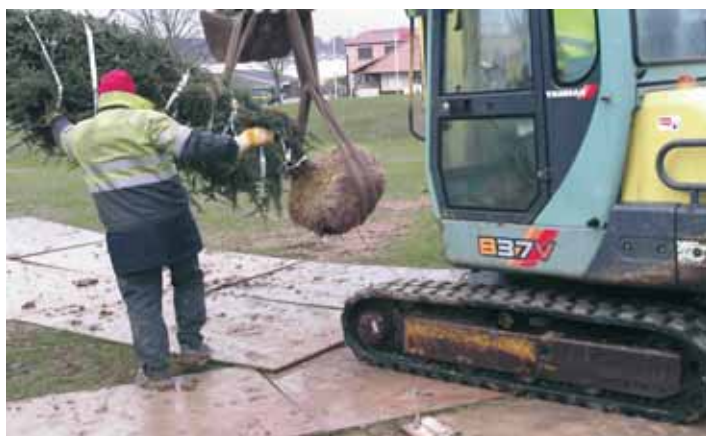
Mise en place de protections spécifiques limitant des risques de destruction des qualités physiques du sol en place.
