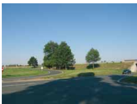
Les échangeurs / diffuseurs
