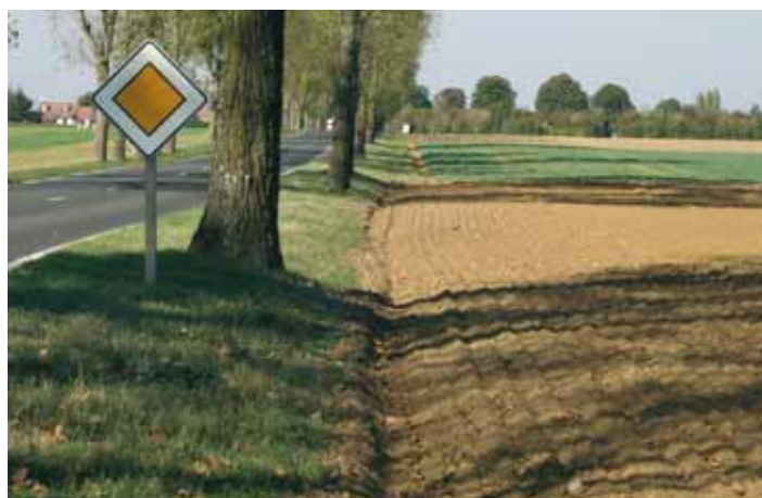
L'intégrité des emprises est une condition majeure à la pérennité du patrimoine arboré. Des travaux agricoles peuvent induire des dégâts importants sur le système racinaire des arbres et altérer gravement leur tenue mécanique
