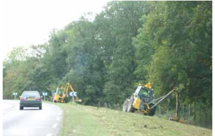
La signalisation lumineuse portée par les véhicules d'intervention est en principe suffisante pour assurer le signalement d'un chantier mobile.
