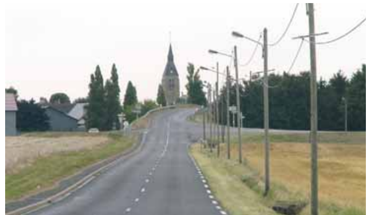
Lieu de passage des réseaux aériens et souterrains
