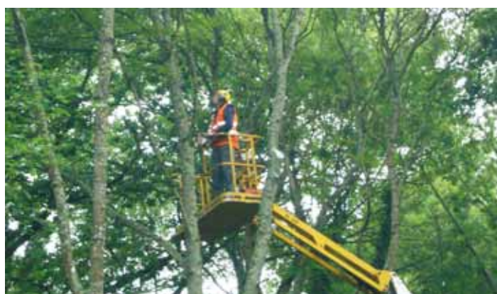
Intervention à la nacelle dans un boisement
