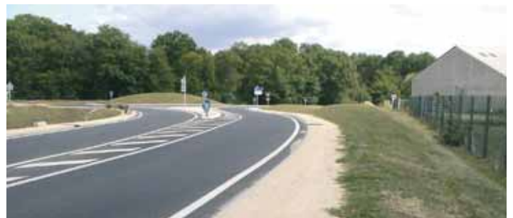
Exemples de surfaces minéralisées au centre ou à proximité de la chaussée
