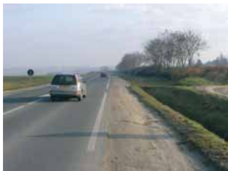
Les accotements (associés aux fossés et noues de collecte)
