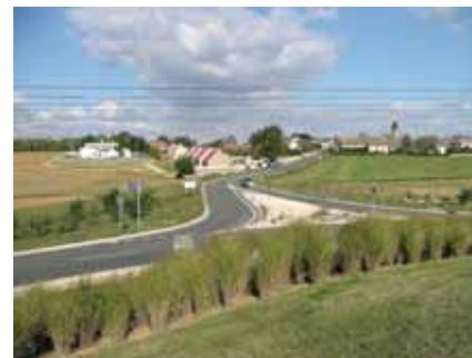
RD 988 PR 14.500 : entrée d'agglomération (Gometz la Ville)
