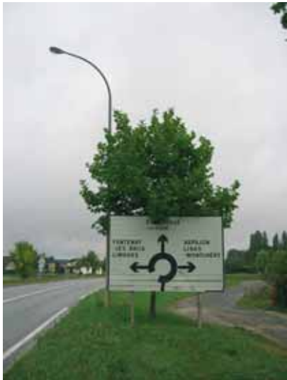
Lacune d'entretien (dégagement du panneaux de signalisation)
