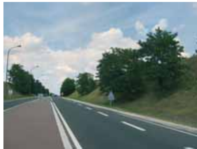
Les merlons, butte et talus
