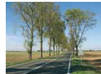
Réhabilitation* : renouvellement complet du patrimoine
