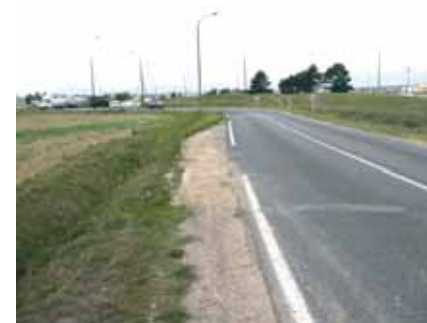
RD 117 PR 25.900 : zone d'arrêt (en arrière plan rond-point avec la RD 19 intégré à l'itinéraire 1.1)
