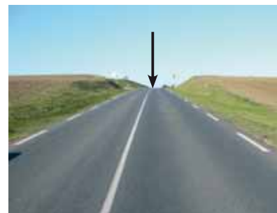
Absence de marqueur signalant les intersections et permettant à l'automobiliste d'anticiper sa conduite
