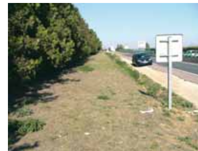
Support des panneaux d'information et de signalisation Zone de sécurité ou de récupération pour les arrêts en dehors de la chaussée et les sorties de route
