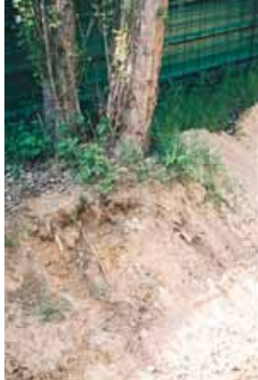
Racines sectionnées lors de la réalisation du fossé
