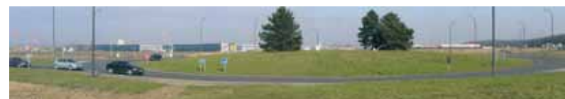
RD 19 PR 13.300 : rond-point nécessitant un aménagement plus conséquent
