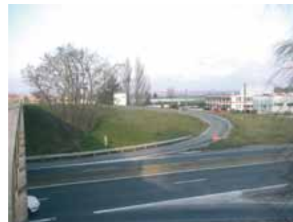
RD 26 PR 4.700 : échangeur avec la RN 20, aménagement à compléter
