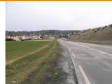
RD 97 PR 9.200 : talus de l'autoroute A10
