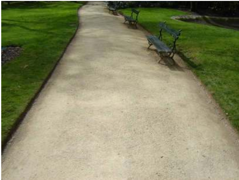
Une allée compactée en février 2008
