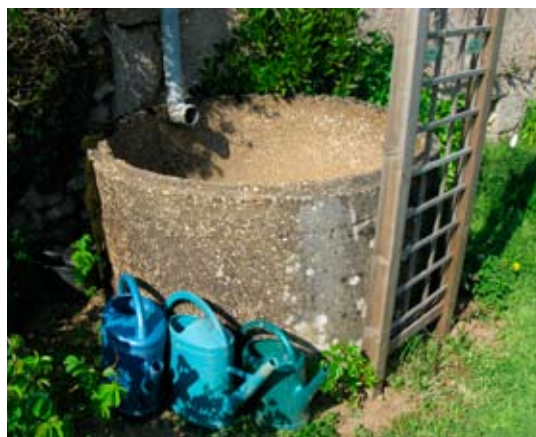
Photo 18 : cuve de récupération d'eau de pluie
